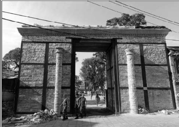
तानसेनको शितलपाटीमा रहेको ऐतिहासिक एवं पर्यटकीय स्थल पाल्पादरबार परिसरको मूलढोकाको निर्माणकार्यमा ढिला सुस्ती । तस्विर : सुमित रेग्मी/एनजेडी
